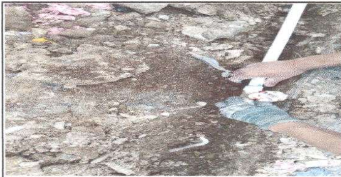
FOTO 9: Instalación de dos llave de paso.
