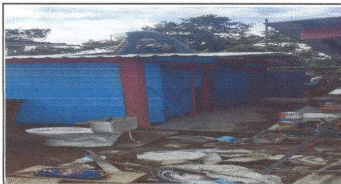
FOTO 11: Mantenimiento a cuatro puertas de Servicios Sanitarios.
